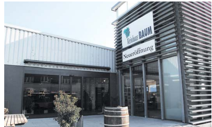
Die neuen Räumlichkeiten des Weinhauses »Baum« in der Eisenbahnstraße haben seit dem vergangenen Wochenende geöffnet.
