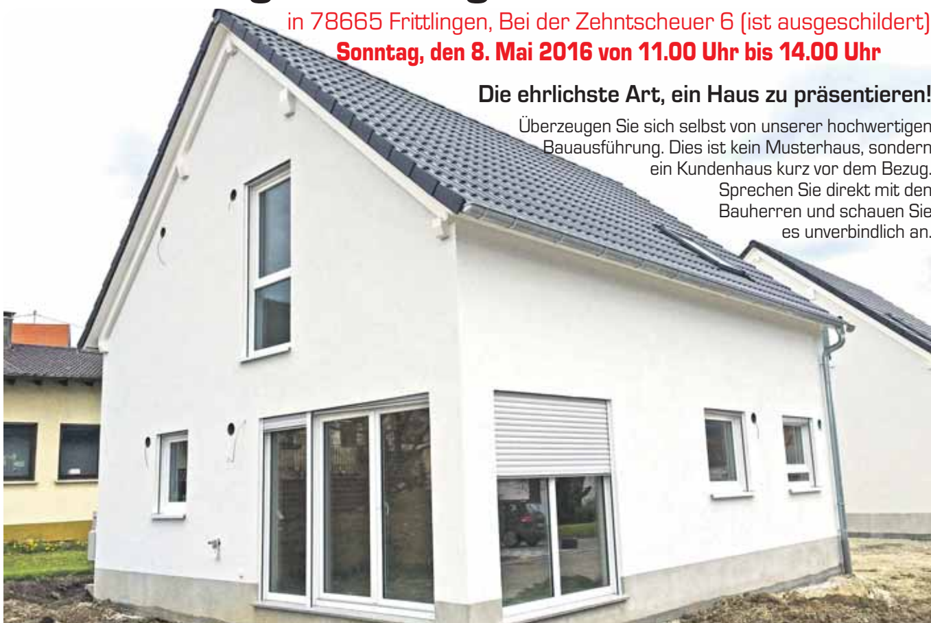
Haustyp – Massiv »Loop Color« auf Bodenplatte mit Fußbodenheizung und einer Luft-Wasser-Wärmepumpe.
