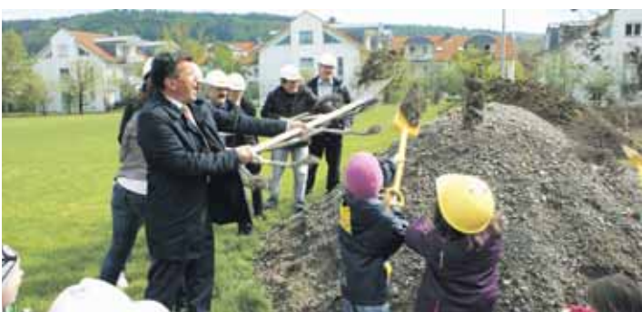
Die Kinder halfen beim Spatenstich für ihr neues Kinderhaus eifrig mit. swb-Bild: le
