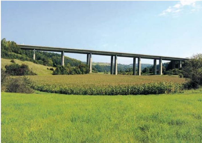
Über 40 Jahre ist die Brudertalbrücke bei Engen alt: nun gab es ernsthafte Schäden an den Rollenlagern, die in einer längeren Aktion ausgetauscht werden müssen. swb-Bild: rp
