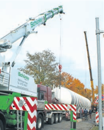
Der erste der beiden je 28,5 Meter langen Behälter wird vor dem Transport auf den Tieflader gehoben.
