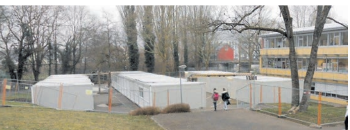
Einige Container auf dem Gelände westlich der Ten-Brink-Schule dienen während der großen Sanierungsmaßnahme für Schüler, Lehrer und Schulleitung als Unterrichts- und Verwaltungsräume. sub-Bild: Regitz
