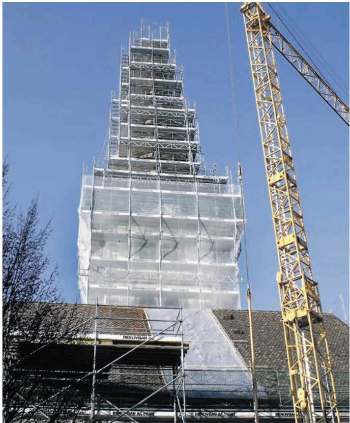
Das Baugerüst an der Stadtkirche ist 40 Meter hoch. swb-Bild: ri
