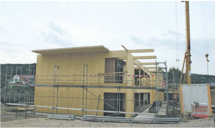
Das neue Kinderhaus in Steißlingen nimmt mehr und mehr Gestalt an.
