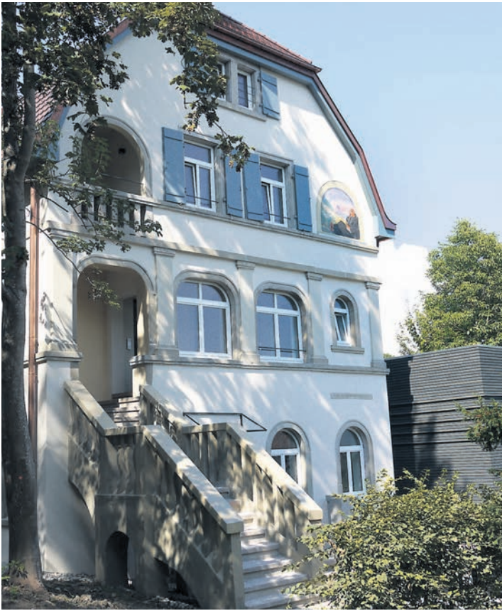
Der historische Teil der Villa an der Klinik kommt genauso zur Geltung wie der moderne Anbau.
