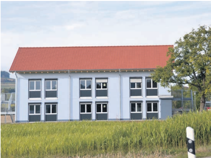
Die neue Gemeinschaftsunterkunft am Bahnhofle in Neuhausen ist fast fertiggestellt. swb-Bild: mu
