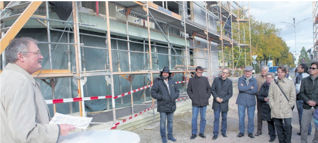
Mit drei kräftigen Schlucke waren es die Maurer des Unternehmens »Hausbau Huber« aus Bodman, die den Spruch zum Deckenfest an der Singener Burgstraße zum Besten gaben, bevor das Glas in die Tiefe geschleudert wurde.
