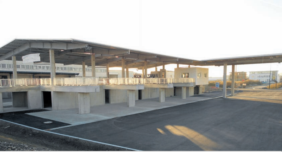
Der neue Wertstoffhof auf dem ehemaligen Okle-Grundstück zwischen »Gaissenrain« und »Freibühlstraße« ist fast fertig, erklärte Stadtwerke-Chef Markus Schwarz gegenüber dem WOCHENBLATT. Außer ein paar Feinarbeiten müsse nur noch der Zaun montiert werden. Mit der Eröffnung des kundenfreundlichen Wertstoffhofes wird Anfang oder Mitte März gerechnet. Zudem dürfen sich die Singener dann auf eine deutliche längere Öffnungszeit freuen.
