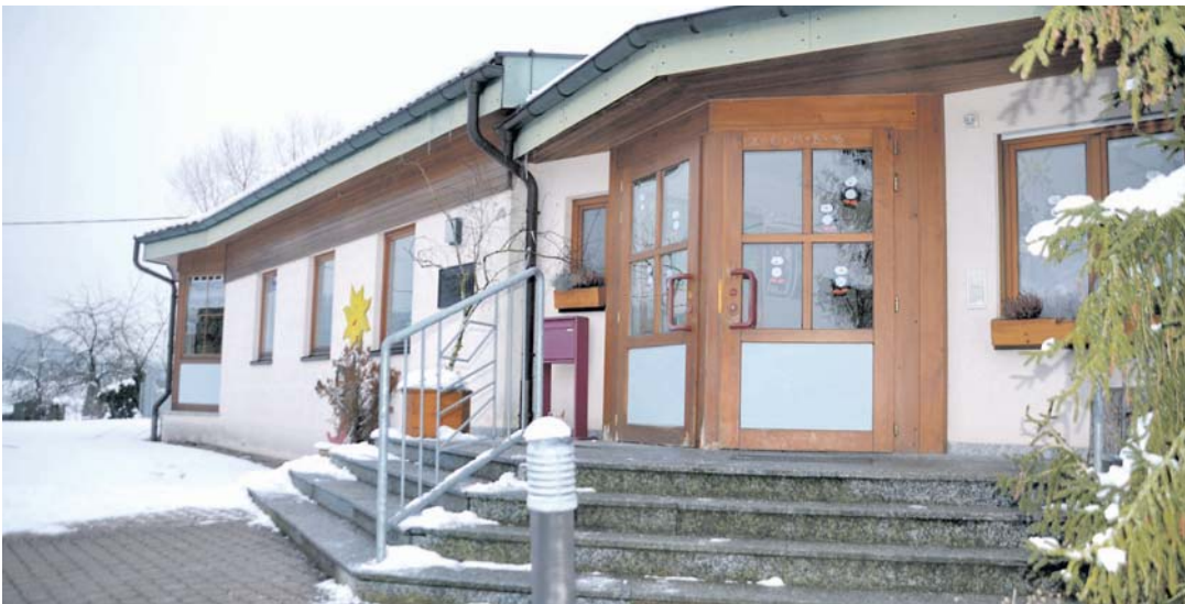
Der Kindergarten in Zizenhausen wird für 1,63 Millionen Euro umgebaut und erweitert. swb-Bild: sw
