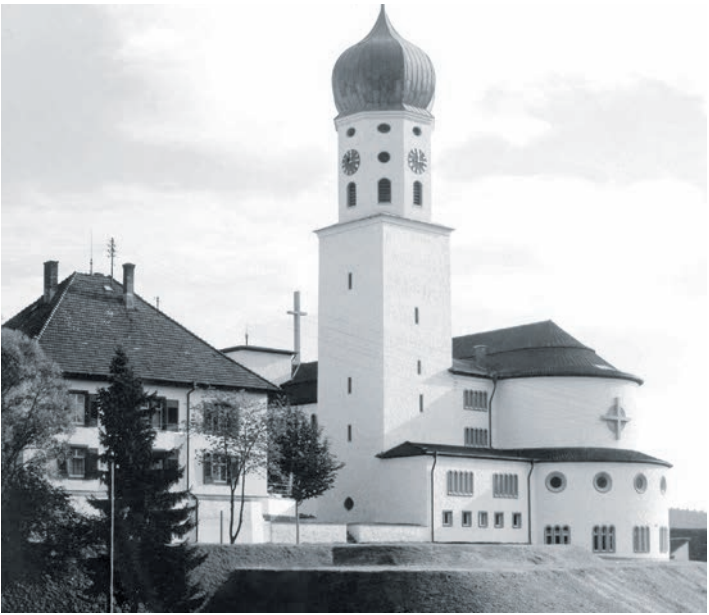
1928 wurde Otto Linder mit Entwürfen für den Neubau der Stockacher Stadtkirche beauftragt. Er war kein unbeschriebenes Blatt, hatte bereits moderne Sakralbauten geschaffen, galt als »Kirchenbaumeister«. Über sein Schaffen und seinen Beitrag zur Errichtung der St. Oswald-Kirche mit dem Zwiebelturm spricht der Kunsthistoriker Dr. Andreas W. Vetter am Montag, 11. April, um 19 Uhr im »Alten Forstamt« in Stockach. swb-Bild: Stadtmuseum Stockach
