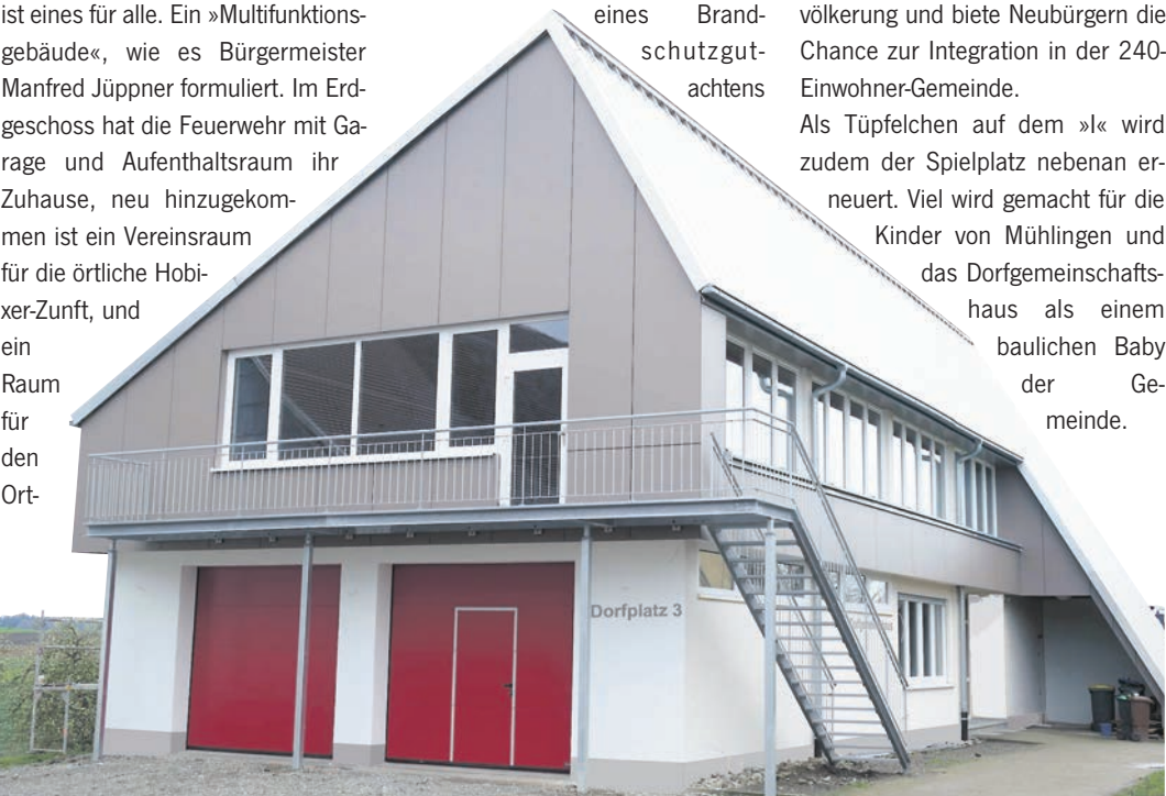
Das Dorfgemeinschaftshaus in der Dorfmitte von Mainwangen bei der Kirche wurde renoviert und wird am Sonntag, 30. Oktober, eingeweiht. swb-Bild: Gemeinde Mühlingen
