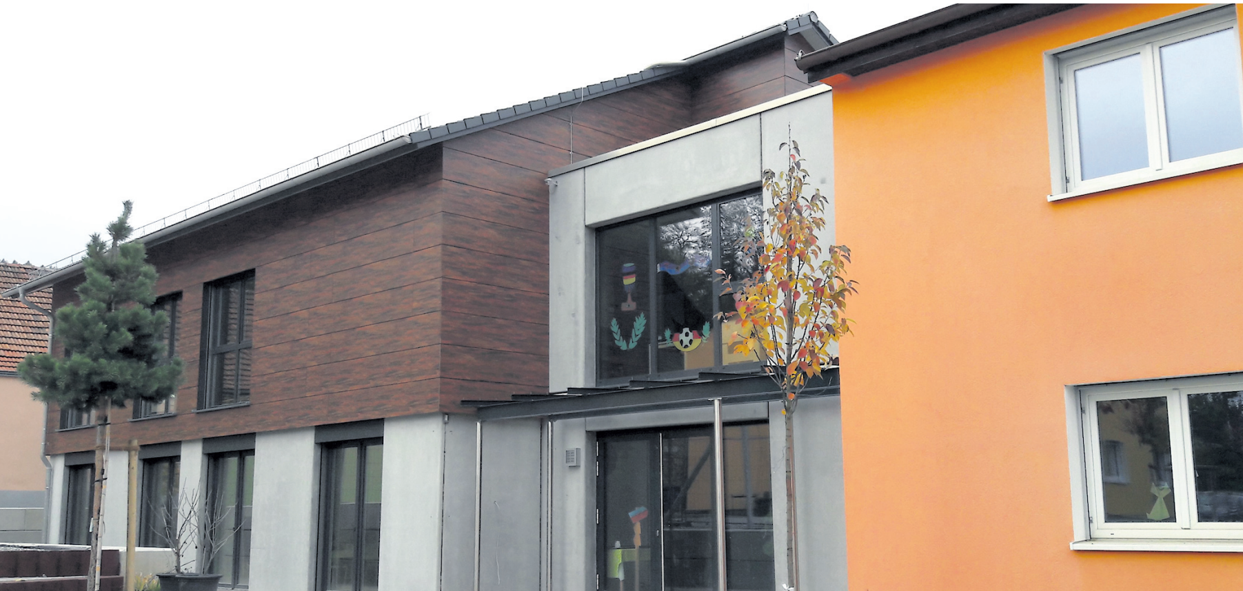
Die gestiegene Nachfrage, Raumnot und Platzmangel hatten den Neubau des Schülerhorts im Stegwiesen in Stockach nötig gemacht, dessen Außenanlagen nun fertiggestellt werden konnten. swb-Bilder: Stadt Stockach
