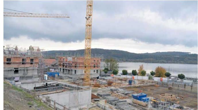
Bodmans neues Gesicht: Richtfest wurde auf der »Gräßlichen Seedomäne« begangen. swb-Bild: sw
