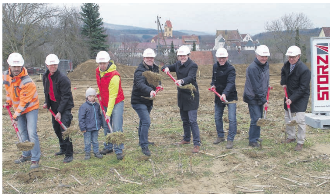
Mit einem zünftigen Spatenstich wurden die Erschließungsarbeiten für das kleine Baugebiet »Schlossblick« am Montag in Blumenfeld gestartet.
