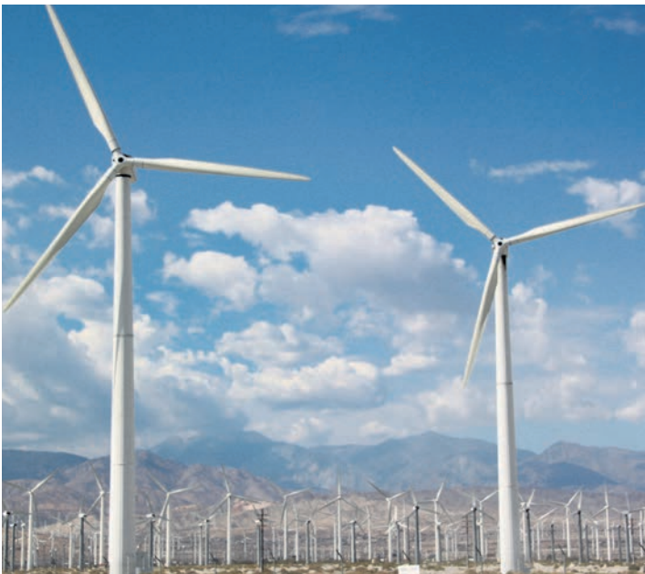
Streitthema Windanlagen: Stockach sagt »ja«, Orsingen-Nenzingen »nein« zur immissionsschutzrechtlichen Genehmigung zweier Anlagen auf der Steißlinger Gemarkung des Kirnbergs. swb-Bild: sw
