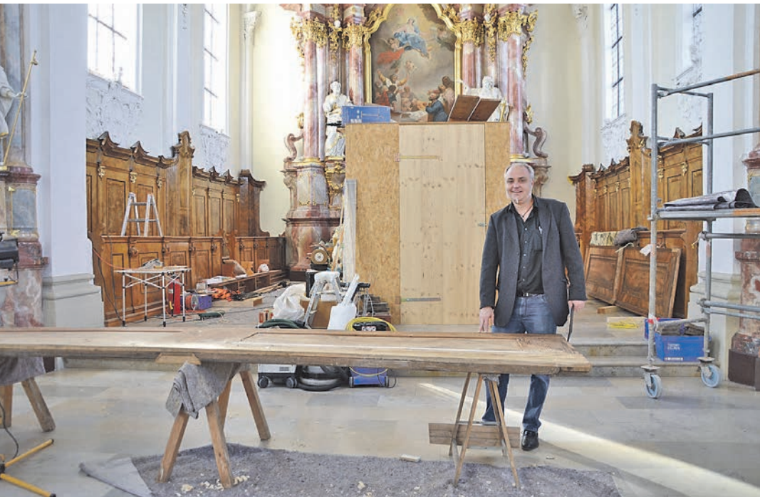
Andreas Wieser an einer Werkbank vor dem Chor der Pfarrkirche St. Peter und Paul. In der Mitte des Chores steht eine hölzerne Lagerbox, in der kostbare und fragile Kirchengegenstände während der Restaurierungsarbeiten geschützt wurden.
