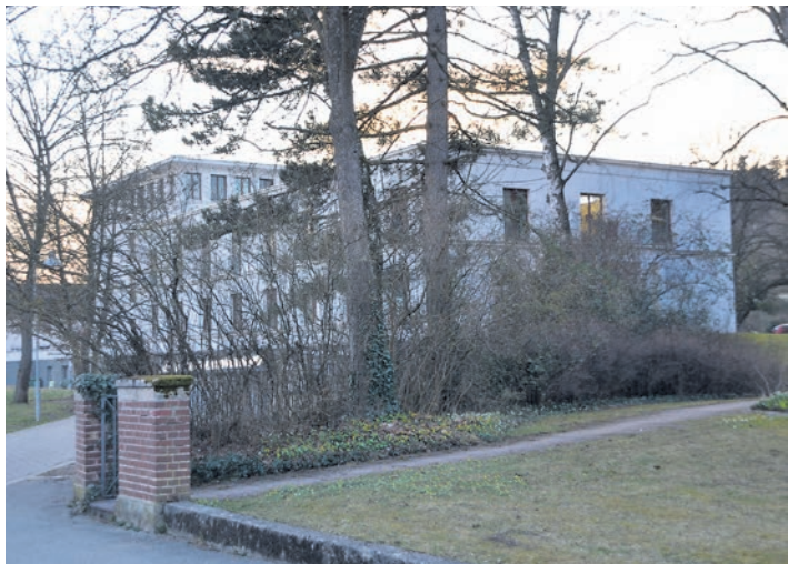
An das Pflegezentrum Hegau wird angebaut.
