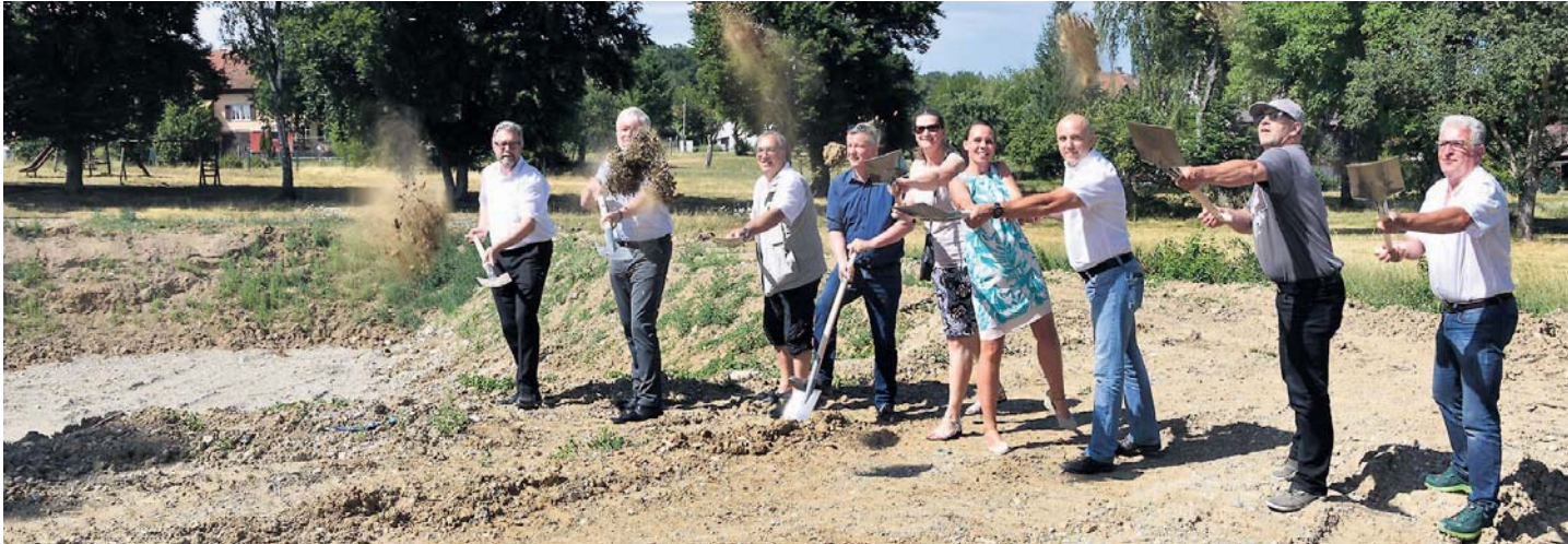
Mit viel Elan schwingen die Beteiligten beim Spatenstich für die Erschließung der Dorfmitte die Schaufeln.
