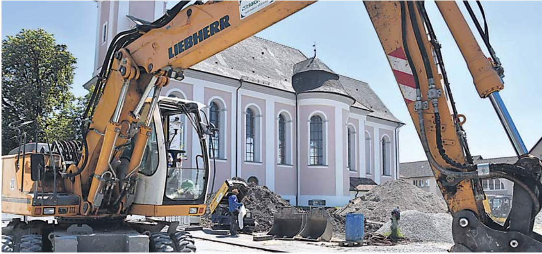
Die Aushubarbeiten auf dem Dorfplatz gestalten sich teurer als erwartet.
