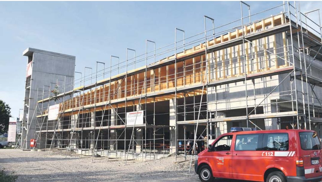
Trotz derzeitiger Verzögerungen soll der Bauzeitenplan für den Neubau des Feuerwehrgerätehauses in Hilzingen einigermaßen eingehalten werden.
