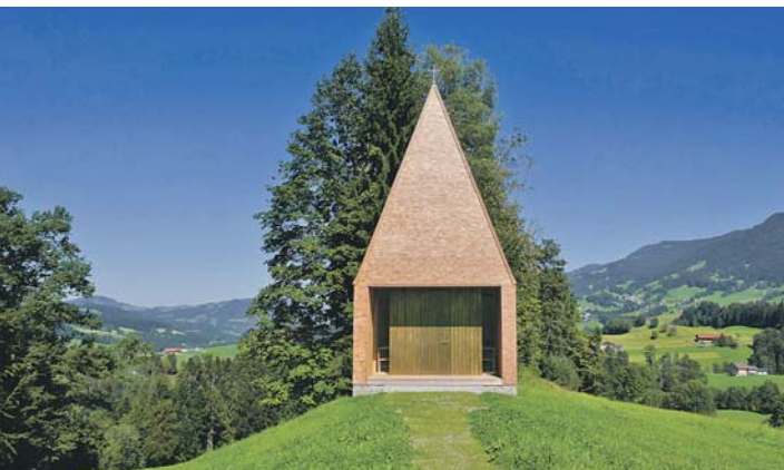
Besondere Architektur: die Kapelle Salgenreute in Krumbach im Bregenzer Wald. swb-Bild: FöKuHei
