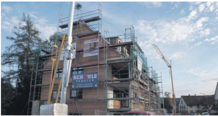
Für das soziale Wohnungsprojekt Rosenegg der KEG Rielasingen-Worblingen konnte am Freitagabend Richtfest gefeiert werden.
