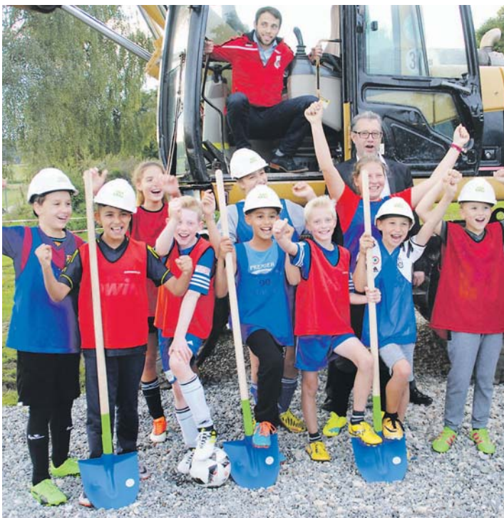
Ein lang geträumter Traum geht endlich in Erfüllung. Vor allem bei den Büsinger Jungfußballern ist die seit dem Spatenstich groß. Im Hintergrund Vereinspräsident Elias Meier(rechts) und Bürgermeister Markus Möll.
