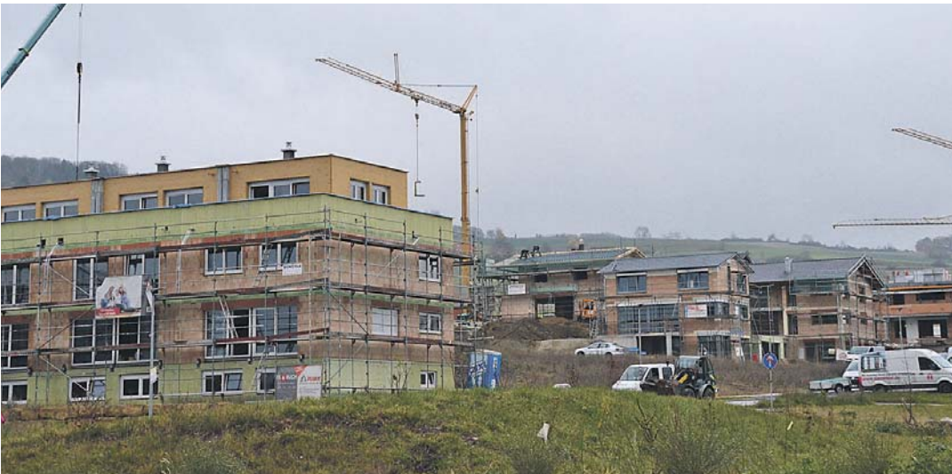
Am Steppachwiesle in Hilzingen wird intensiv gebaut.
