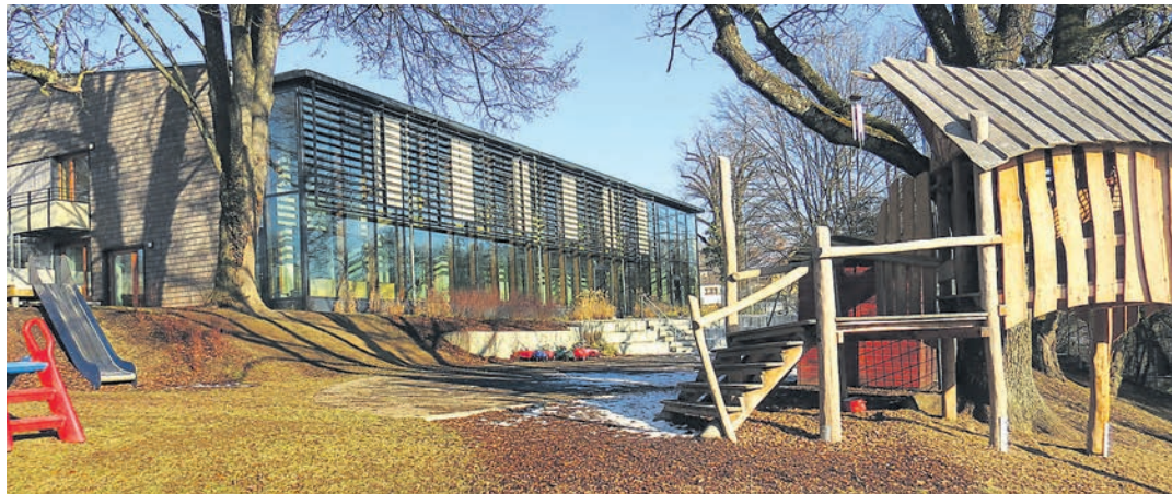
Sechs Jahre nach der ersten Planung und nach rund zwei Jahren Bauzeit wird das neue Kinderhaus »Bullerbü« Ende April offiziell eröffnet. swb-Bild: Ortsverwaltung
