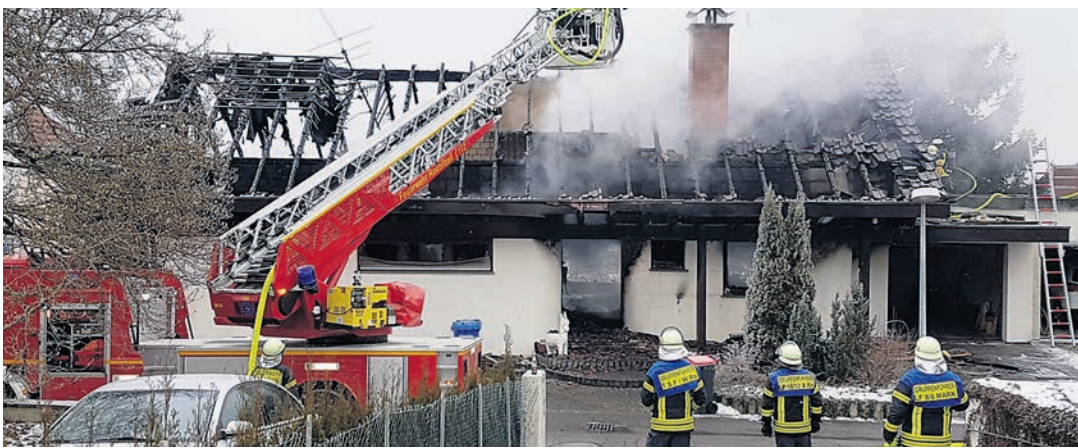
Bei einem verheerenden Brand verloren sechs Menschen in Radolfzell am vergangenen Mittwoch ihr Zuhause. swb-Bild: Feuerwehr
