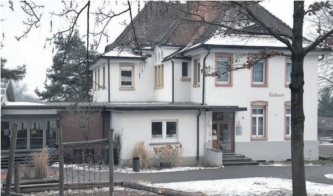
In Güttingen soll der Platz vor dem Rathaus in 2017 saniert und aufgewertet werden. Im Zuge dessen sollen das Rathaus und die Schule barrierefrei werden. swb-Bild: gü
