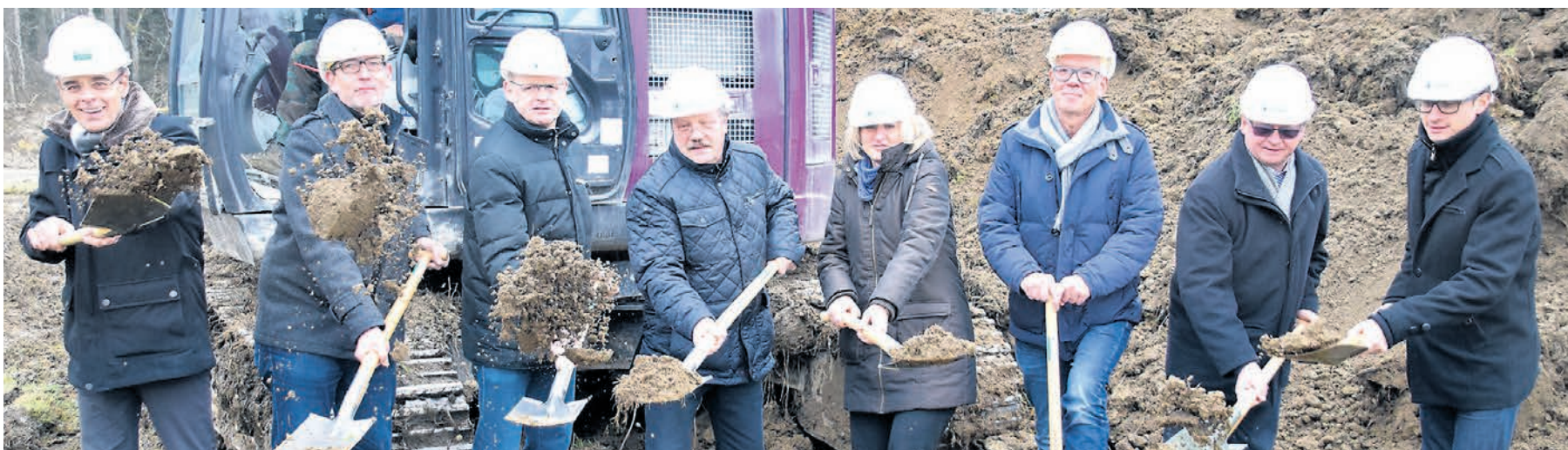
Packten beim Spatenstich für die neue Seniorenwohnanlage in Moos kräftig mit an: Karl-Edmund Haug, Bürgermeister Peter Kessler, Gemeinderat Karlheinz Bölli, Seniorenrat Jörg Junggunst, Hauptamtsleiterin Martina Stoffel, Architekt Thomas Krämer sowie die Koordinatoren Gerhard und Michael Fischer.
