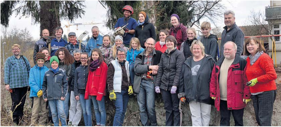
Über 30 fleißige Helfer des Bauförderkreises St. Laurentius in Markelfingen haben mit der Sanierung der Kirchenmauer begonnen.
