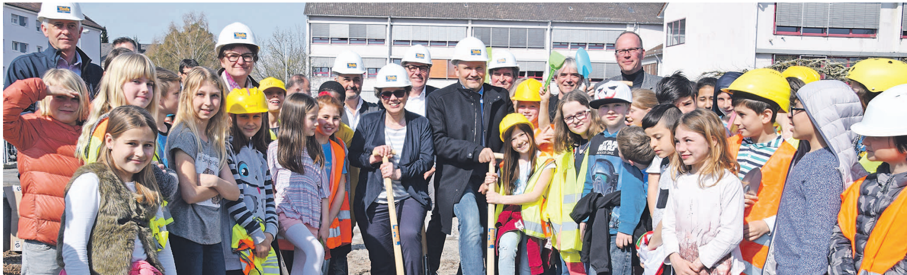
Die Schüler der Ratoldus-Gemeinschaftsschule packten beim Spatenstich des geplanten Neubaus gleich ordentlich mit an. Über so viel Unterstützung freuten sich unter anderem Oberbürgermeister Martin Staab und Rektorin Angelika Haarbach (Bildmitte).
