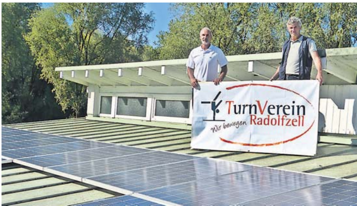
Auf 61 Quadratmetern produziert eine Fotovoltaik-Anlage seit Kurzem auf dem Dach des Turnerheims des TV Radolfzell Strom aus Sonnenenergie.
