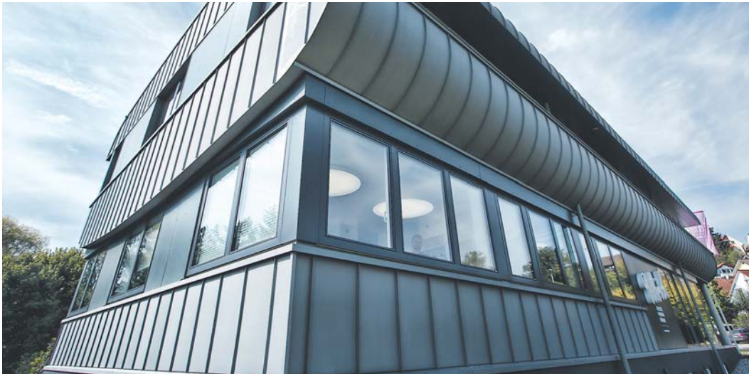
Ein Gebäude, das polarisiert: die futuristischen Formen der Praxis für Kieferorthopädie von Dr. Marc Ullrich an der Dillstraße in Stockach. swb-Bild: Katrin Zeidler
