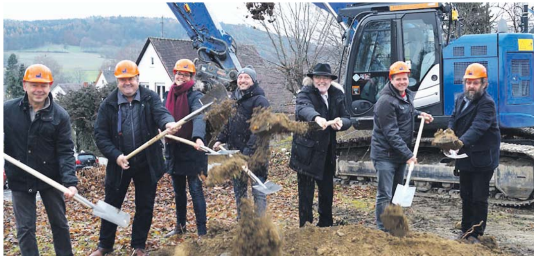
Mit ihrem Spatenstich haben sie den Weg für den Neubau des Kindergartens in der Franz-Schubert-Straße, Ecke Richard-Wagner-Straße in Stockach, kraftvoll und unter Beifall vieler Gemeinderatsmitglieder eingeläutet. Über das vorweihnachtliche Geschenk freuen sich (v. l. n. r.) Manfred Raff vom Bauamt, Manfred Löffler von der Baufirma, die künftige Leiterin Jeanette Schöpf, Architekt Roland Fiedler, Bürgermeister Rainer Stolz, der für die Baustatik zuständige Christian Walter und Andreas Raschke von der Firma Geopro. swb-Bild: wh
