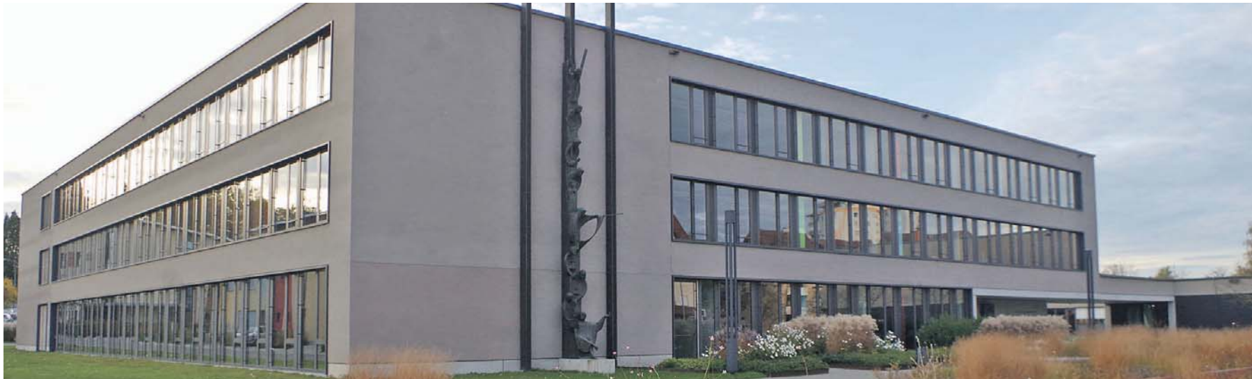
Ein Musterbeispiel nicht nur für Architektur und Kunst am Bau: nach sechs Jahren Bauzeit legte das BSZ Radolfzell in 2017 eine Punktlandung hin.
