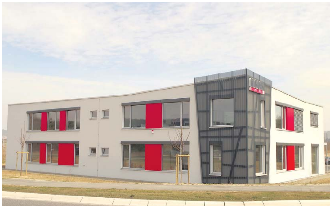
Zum Jahreswechsel konnte der richtungsweisende Neubau von MAIER IT-SYSTEME im neuen Steißlinger Gewerbegebiet »Vor Eichen« bezogen werden. Die Einweihung findet am 5. Mai mit einer »Innovationsmesse« statt.
