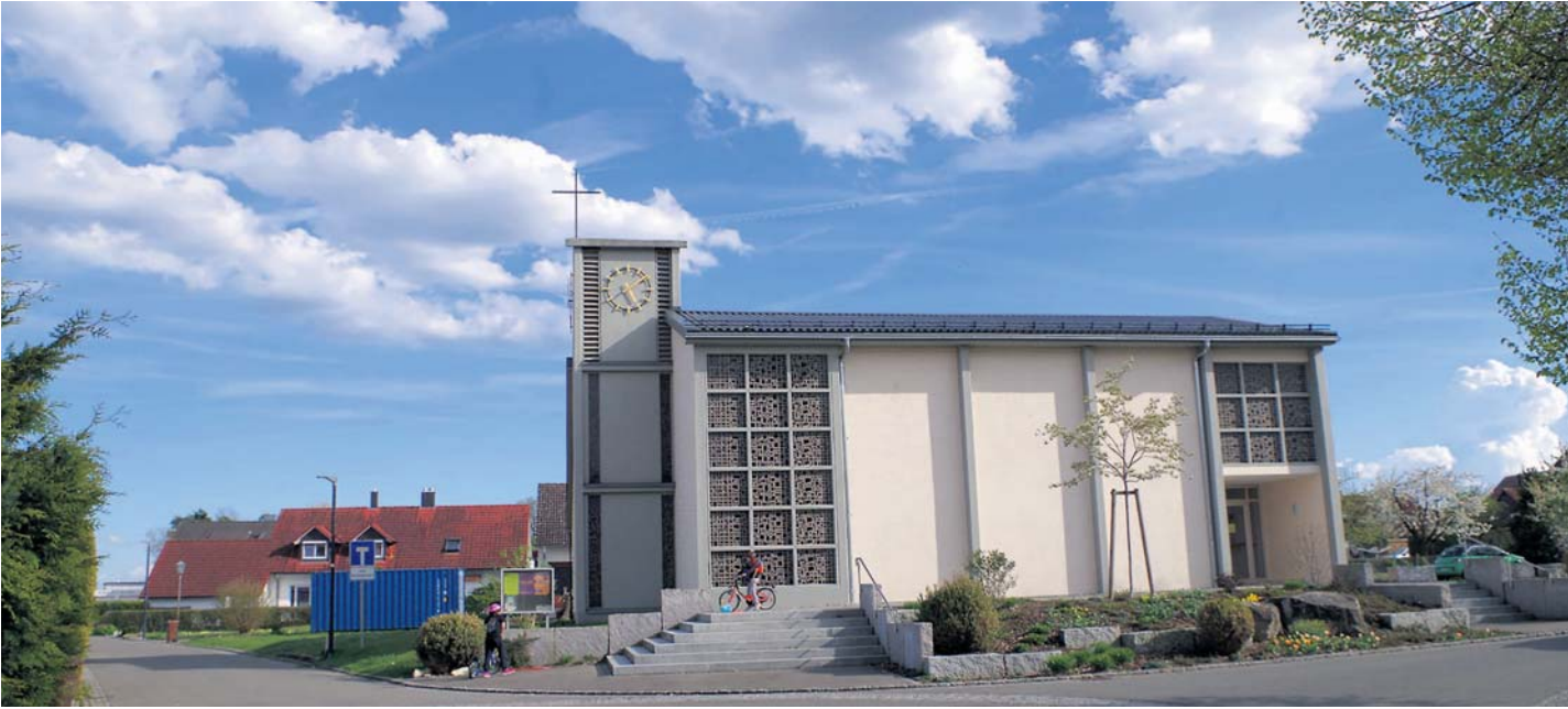
Noch steht die evangelische Christuskirche in Aach alleine auf ihrer Wiese. Doch ab Sommer soll endlich das Gemeindezentrum gebaut werden - wenn die Brandschutzmaßnahmen im Bauantrag genehmigt sind. Das wird der zweite Aufbruch nach Ostern. swb-Bild: of
