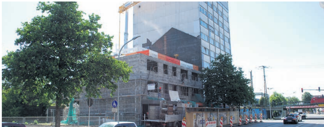
Es geht voran: Das Nebengebäude des Conti-Hochhauses ist schon beträchtlich geschrumpft. Der Blick vom Scheffel-Areal (rechts) macht den hohen Aufwand deutlich. Schon bald wird auch das Conti selbst Geschichte sein.
