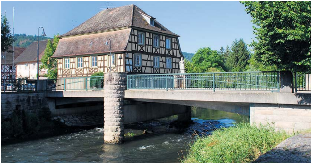
Die Aachbrücke in Bohlingen wird ab 4. September gesperrt.
