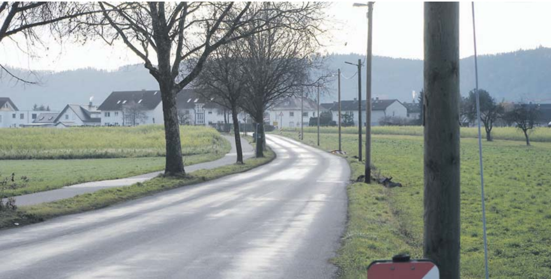
Beim dritten Bauabschnitt der Hardstraßensanierung im Ortsteil Worblingen soll die Straße zum Schutz der Bäume verlegt werden. swb-Bild: of
