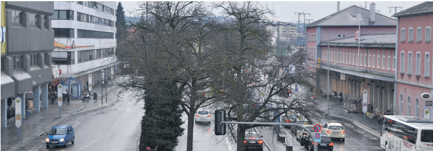
Die Bauarbeiten zur Umgestaltung des Bahnhofsvorplatzes werden erst 2018 begonnen.
