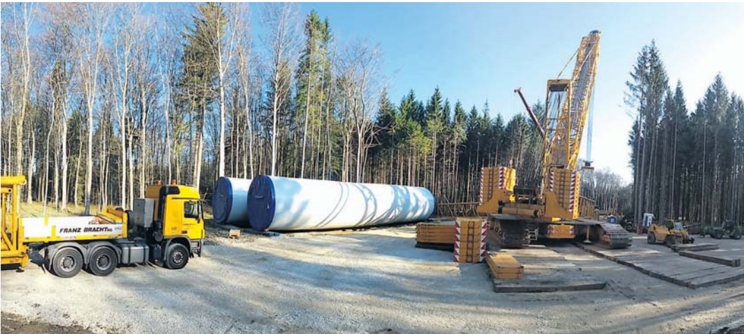
Mit dem riesigen Kran werden die Metallelemente des Windparks aufgebaut. sub-Bild: Seitz
