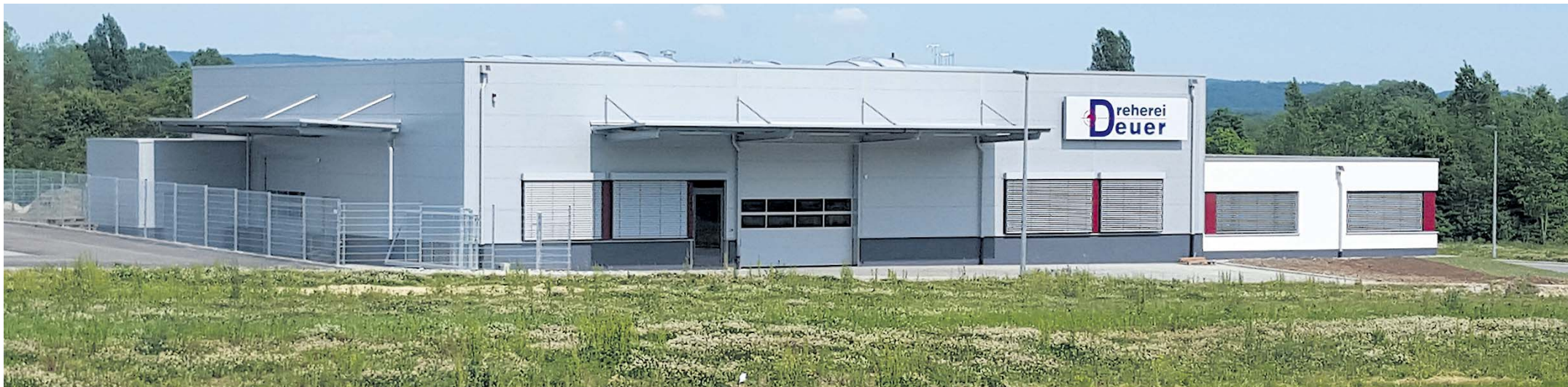
Bestens für die Zukunft gerüstet: Der neue Firmensitz der Dreherei Deuer am Fuße des Hohenkrähen in Mühlhausen-Ehingen.
