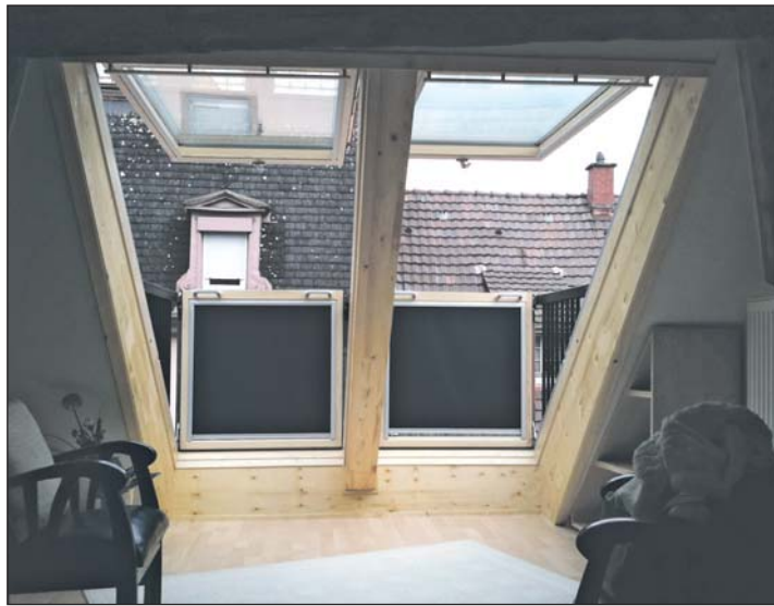
Der Einbau von modernen Dachfenstern wie eines solchen Doppel-Cabriofensters in Form eines ausklappbaren Balkons erhöhen den Wohnkomfort. Die Firma Hirling ist dafür ein kompetenter Ansprechpartner.
