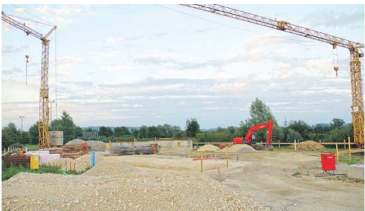
Durch die trockene Witterung im Frühsommer sind die Arbeiten für die neue Wiesengrundhalle ganz im Plan. Der Gemeinderat hat in seiner letzten Sitzung die Arbeiten für die nächste Bauphase im Herbst vergeben.
