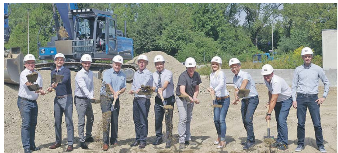
Beim Spatenstich: Bürgermeister Ralf Baumert, Felix, Moritz und Helmut Grimm und Wolfgang Waibel von ELGO, Günter Keller von der Sparkasse Hegau-Bodensee, Michael Simon vom Erdbauunternehmen Schwarz, Nadine Stotz, Geschäftsführer Jürgen Baumeister, Projektleiter Dirk Streubel und Marco Sauter vom Unternehmen Fertigbau Wochner aus Lahr.
