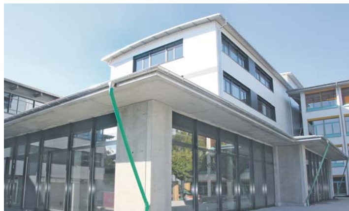
Der Erweiterungsbau der Realschule Stockach wurde fertig gestellt.
