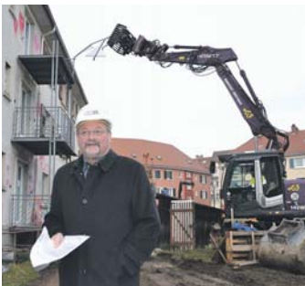
Der Abriss bei den Mehrfamilienhäusern der Baugenossenschaft Hegau in der Romeiasstraße hat wie versprochen begonnen, betont Geschäftsführer Axel Nieburg. swb-Bild: stm
