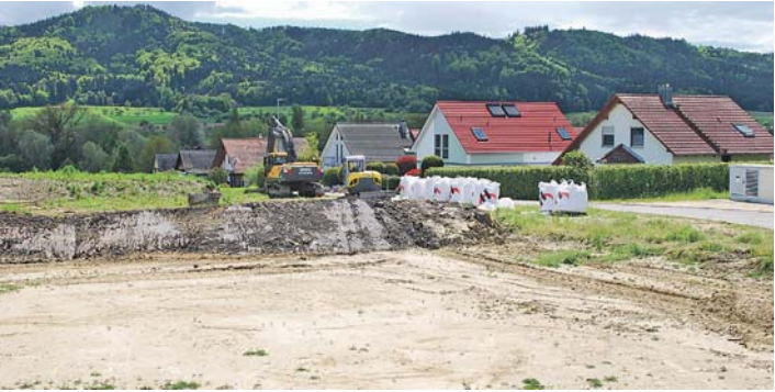
Auch in den Ortsteilen rollen die Bagger: Der Erdaushub beim neuen Baugebiet im »Hinter Hof 3« in Bohlingen ist schon weit fortgeschritten. Hier sollen drei Mehrfamilien-, sechs Doppel- und 35 Einfamilienhäuser entstehen. sub-Bild: dh
