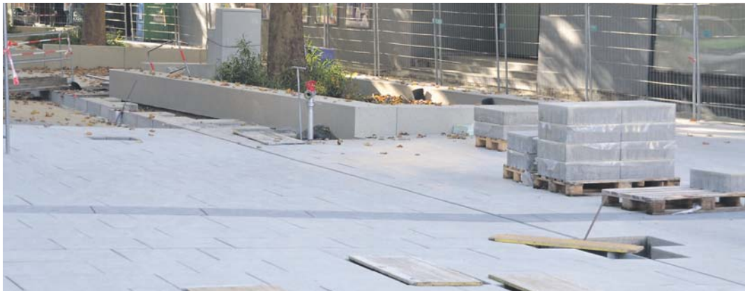
Die Bauarbeiten zur Neugestaltung der Hegaustraße werden noch bis Ende November andauern. swb-Bilder: stm
