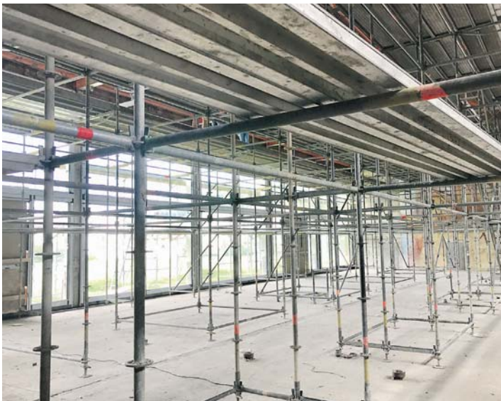
Seit Herbst 2016 wird die Hoahrreinhalle saniert - im Mai soll sie in neuem Glanz erstrahlen.
